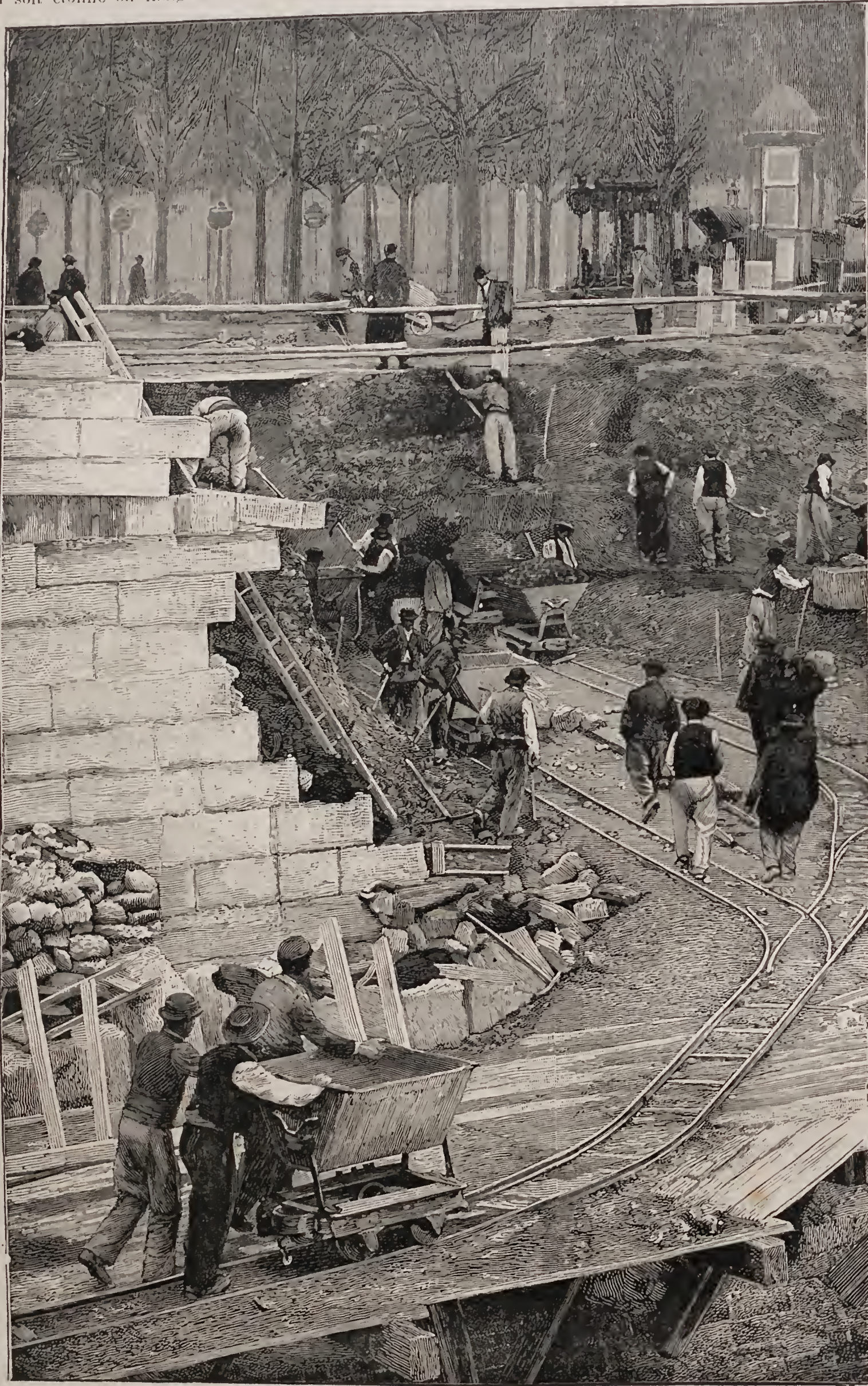
TRAVAUX DE L'EXPOSITION. — Ouverture du premier chantier.
